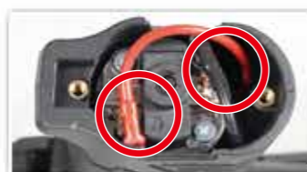
無作動 檢查馬達連接線(需卸下底板)。
