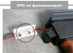
ЭПО не функционирует. Проверьте предохранитель.
